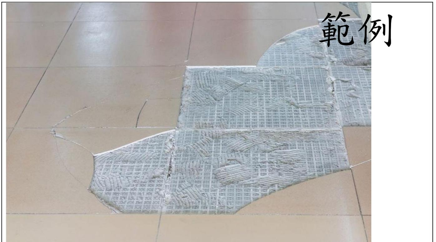
損壞情形概述：地板破損（含磁磚）約20平方公尺
