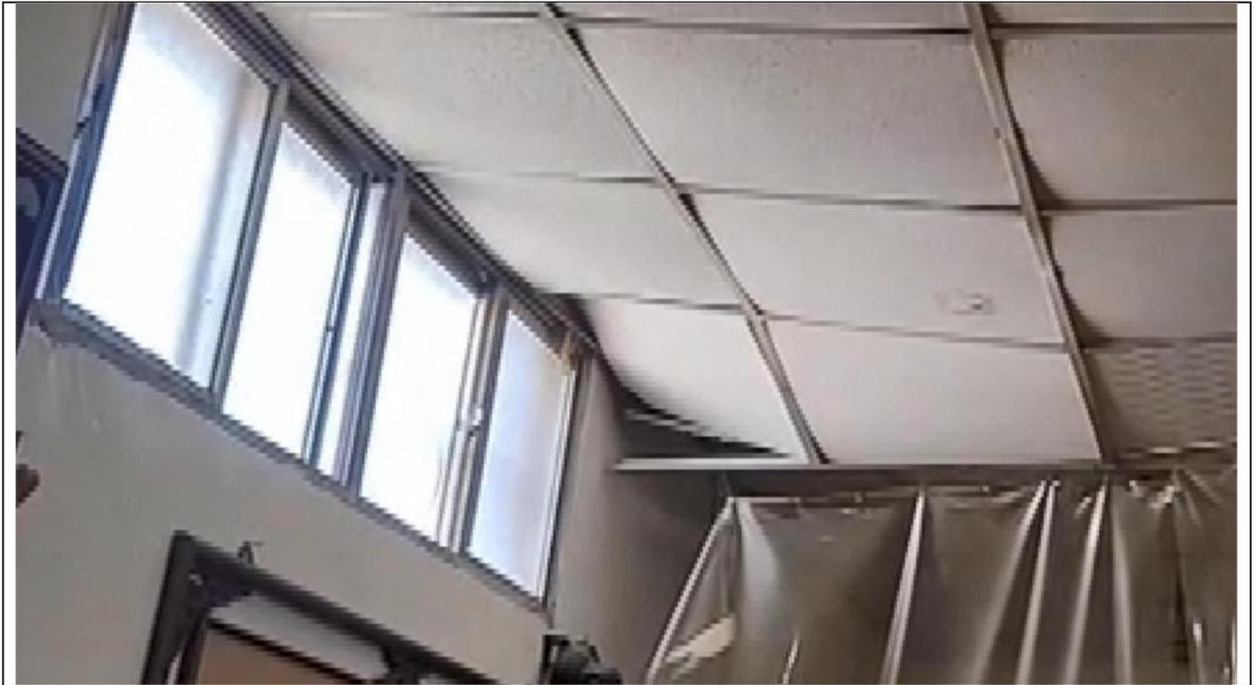
損壞情形概述：天花板輕鋼架變形掉落
