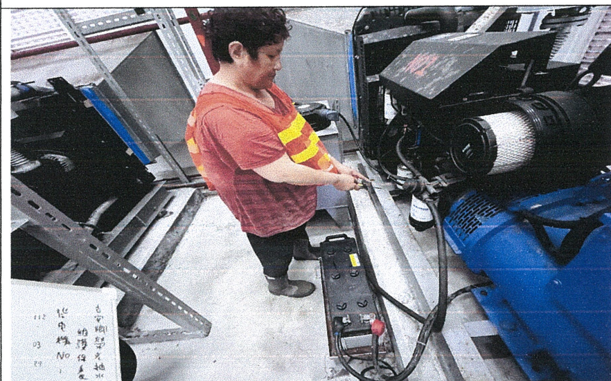
發電機ON維護保養
