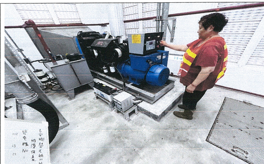
發電機ON試車運轉
