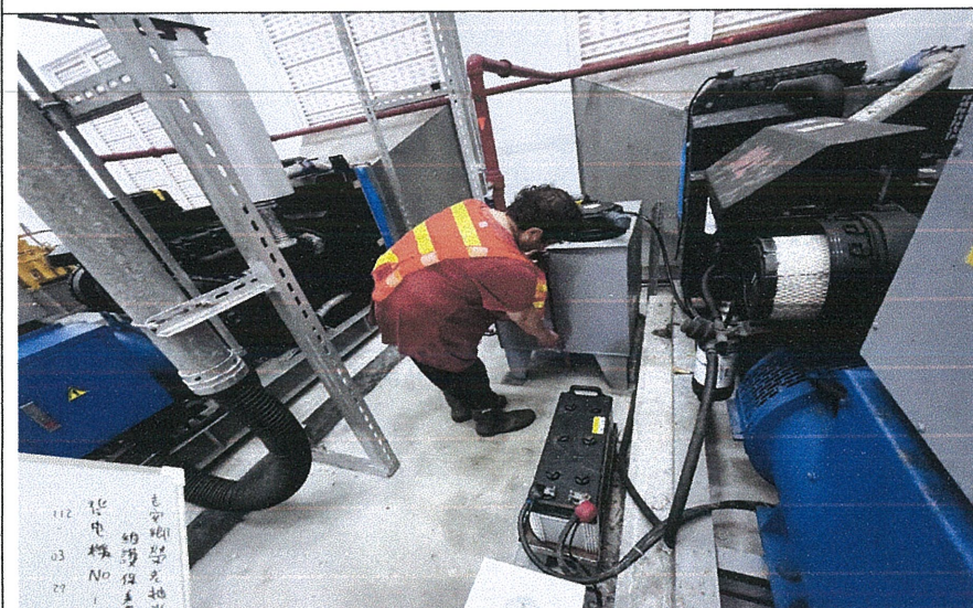
發電機ON維護保養
