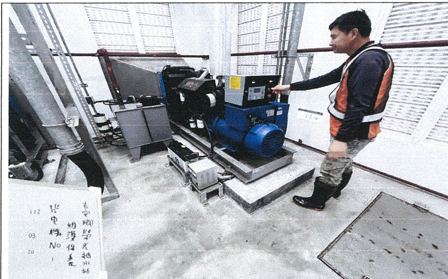
發電機〇二試車運轉
